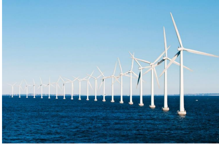
欧州の洋上風力発電所
