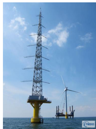
図 3.1 着床式洋上風力発電実証研究施設（銚子沖） 26)
